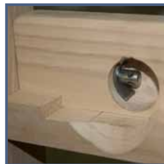
Assemblage du lit avec vis de rappel et étrier en acier
